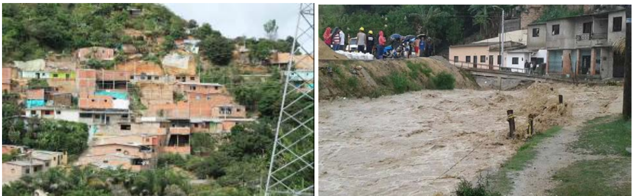
Figura No.1 Asentamientos Humanos en Zonas de Riesgo.
