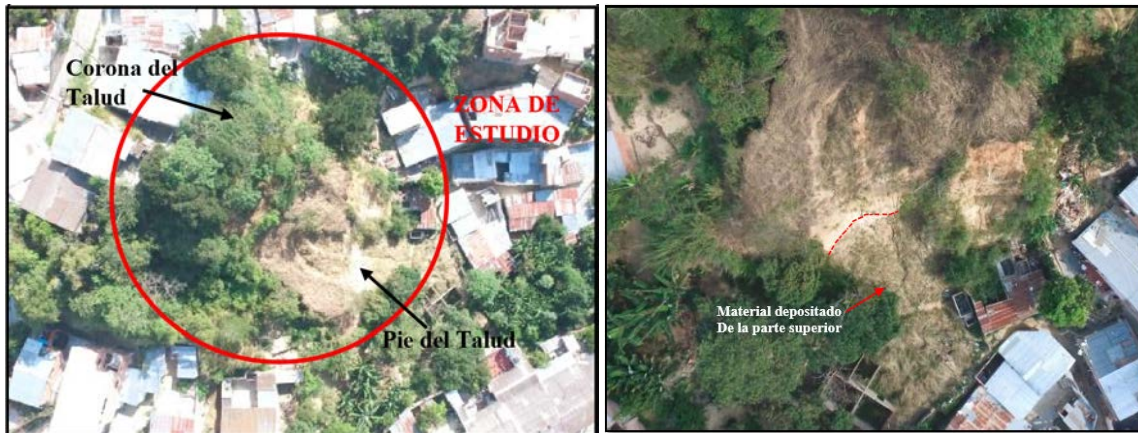
Figura 6. Imágenes aéreas del talud de estudio en el Barrio Olaya Herrera, Ocaña Norte de Santander. Fuente: Vergel & Trillos, 2016.
