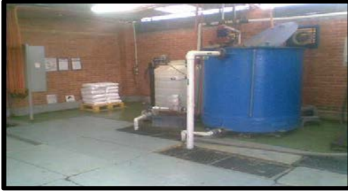
Figura 5. Tanque para el tratamiento de aguas con cromo. Empresa Grifería y Complementos S.A. Funza, Cundinamarca. (Los autores)
