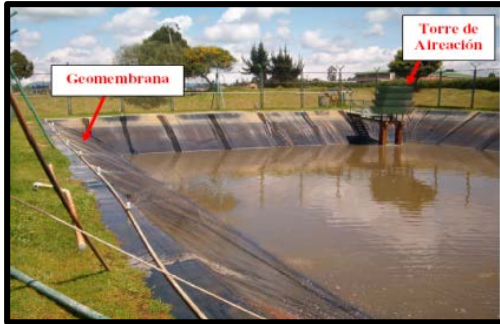
Figura 4. Reservorios de agua industrial. Empresa Grifería y Complementos S.A. Funza, Cundinamarca (los autores)
