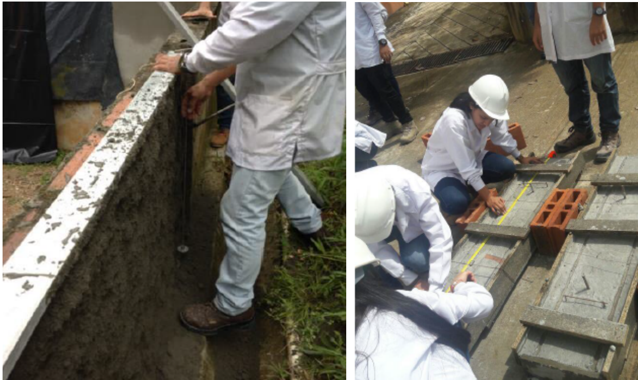
Figura 2: Izquierda, Instalación de frisos impermeabilizados. Derecha, prefabricación de alfajías
