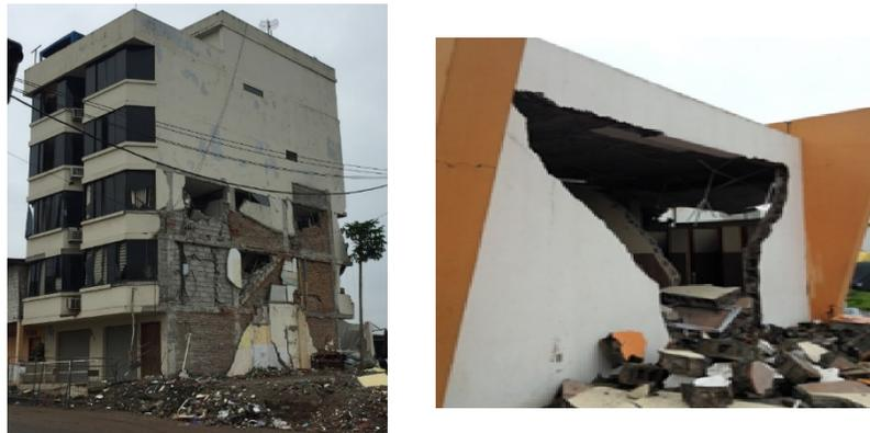
**Figura 1.-** Edificaciones afectadas en el sismo de Pedernales-Ecuador.
